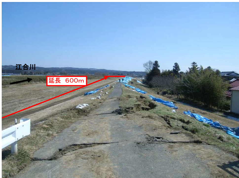
3月19日 堤防の被災状況 堤防沈下
