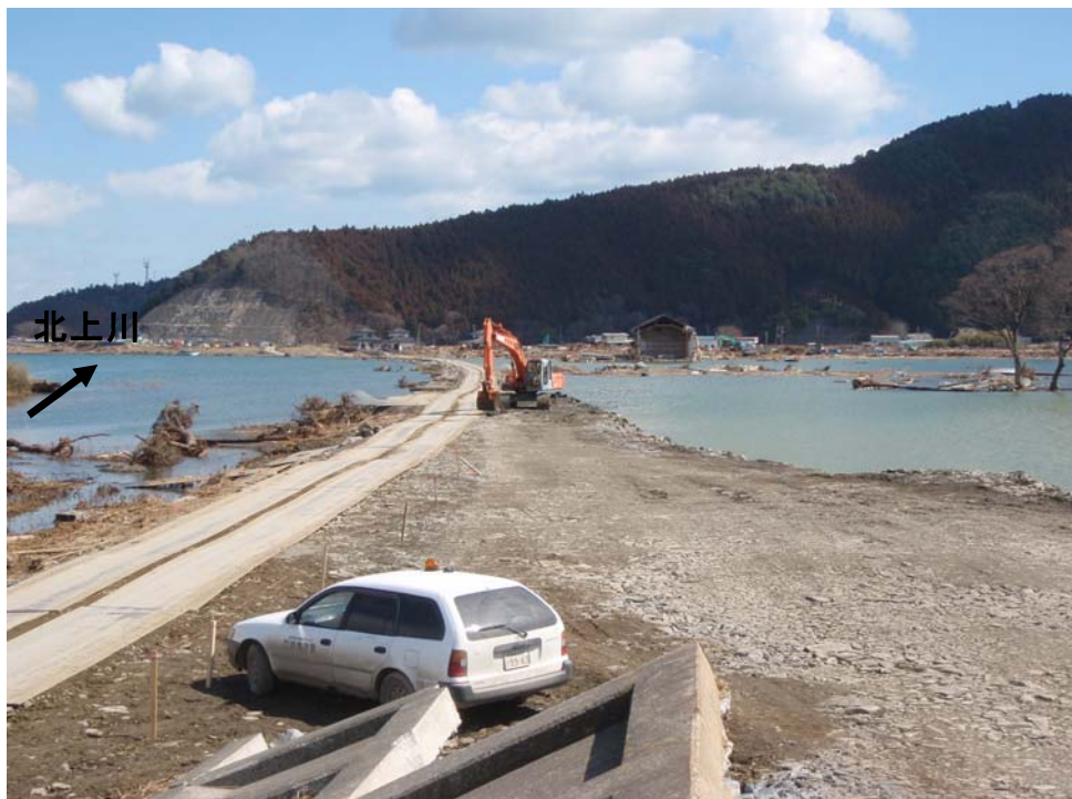
3月27日現在、緊急復旧工事により仮設道路拡幅中。
