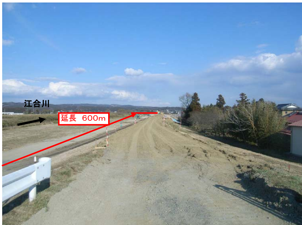
3月28日16時頃 緊急復旧工事による復旧盛土完了
