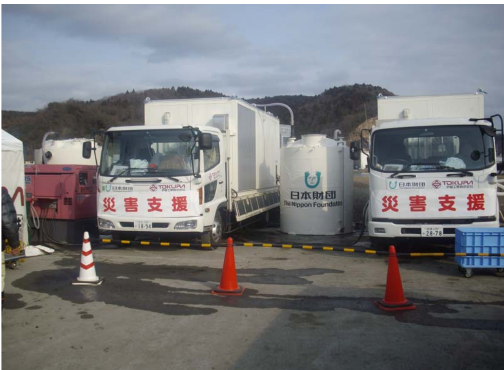
地域の断水に対応して給水する浄化装置に河川水を活用。 (旧北上川右岸:石巻市中央2丁目)
