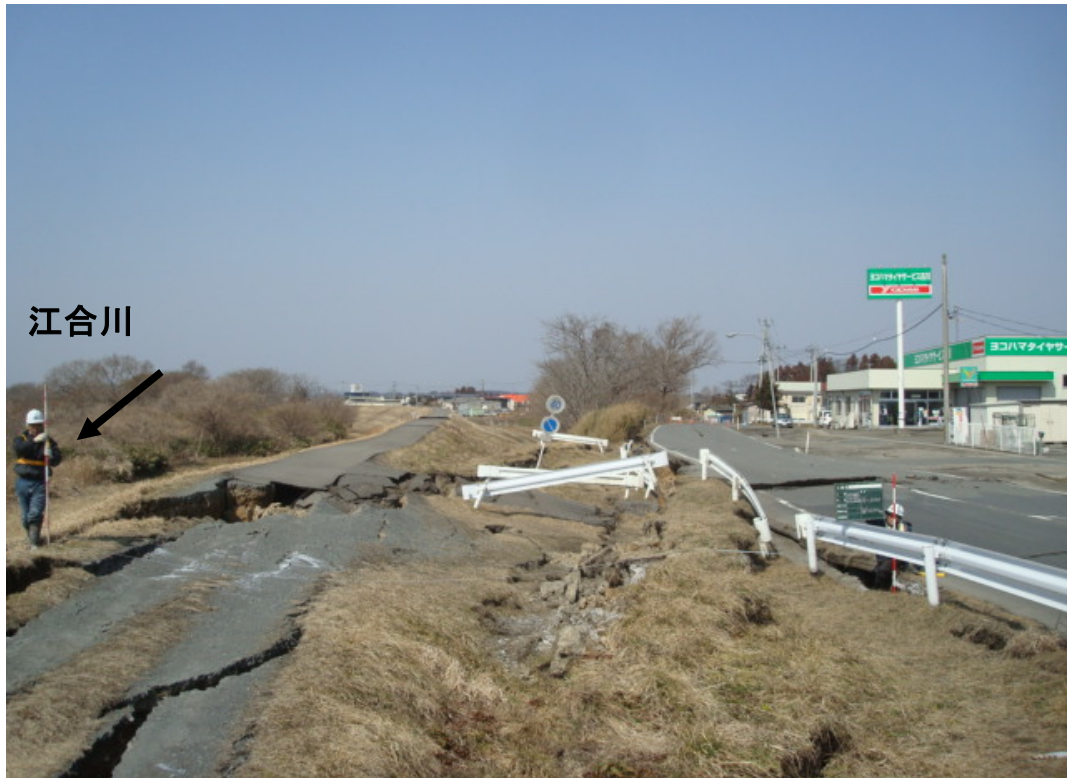
3月11日堤防被害状況 堤防亀裂・沈下
