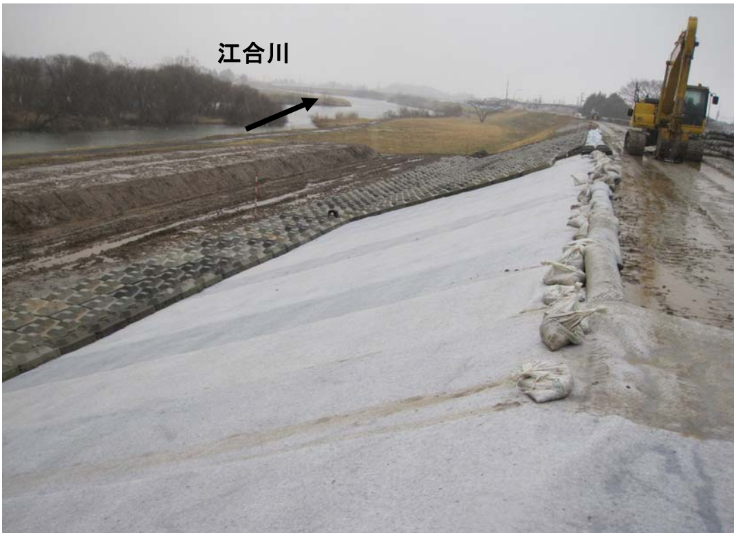
3月26日10時頃 堤防亀裂・沈下の復旧盛土完了しコンクリートブロック張り実施中
