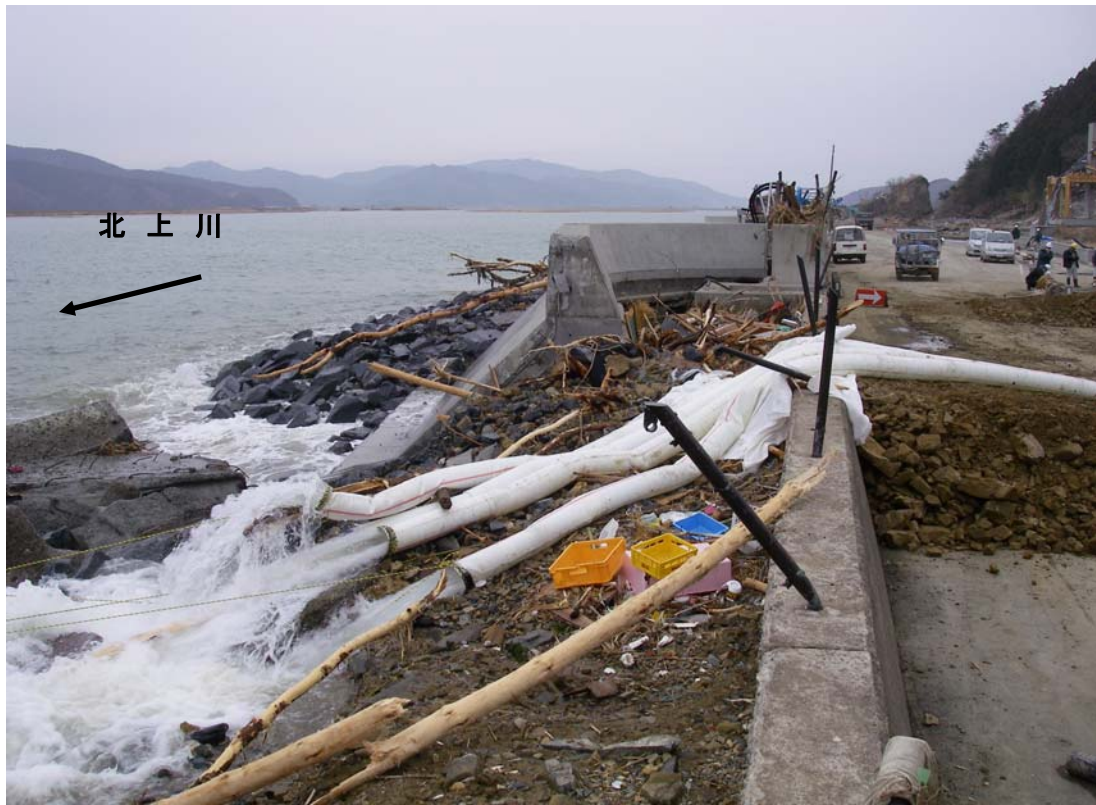
石巻市北上町吉浜小前で月浜沢川閉塞による内水の排除ため排水実施。 ※21日14時頃撮影
