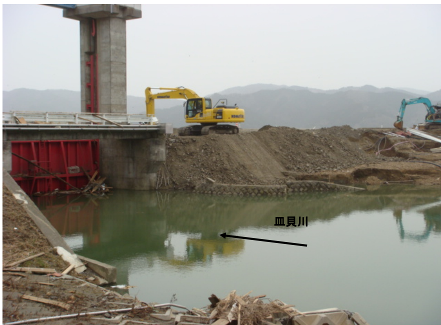
3月20日13時頃 堤防決壊の荒締め切り
