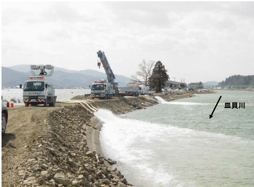
石巻市北上町橋浦、女川の浸水解消のためのポンプ車5台で排水中。
