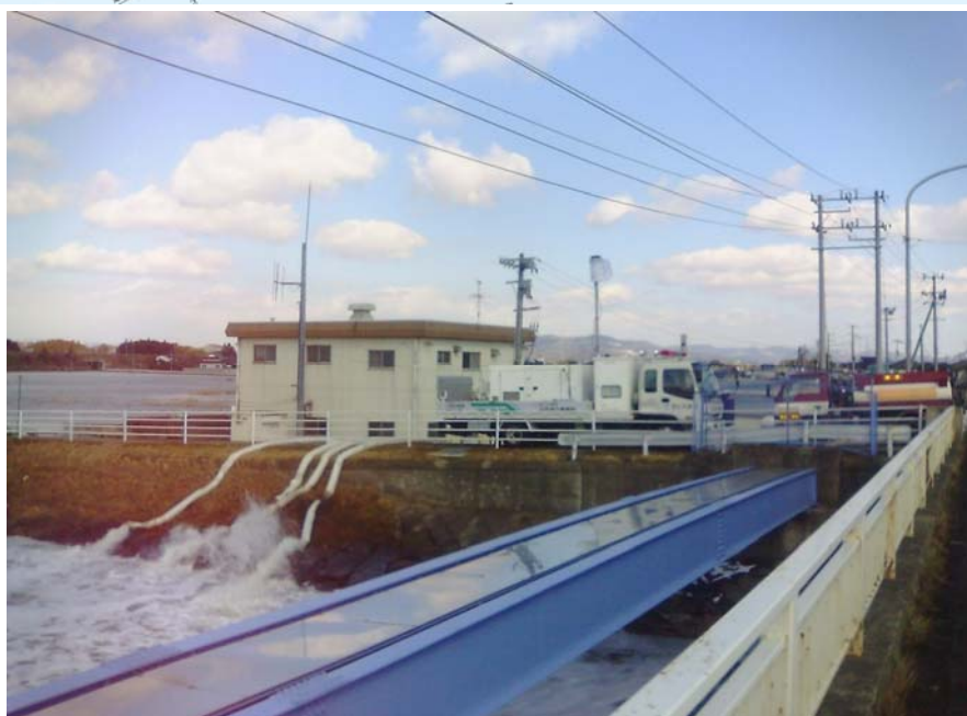
東松島市赤井 赤井排水機場での浸水解消のための排水状況
