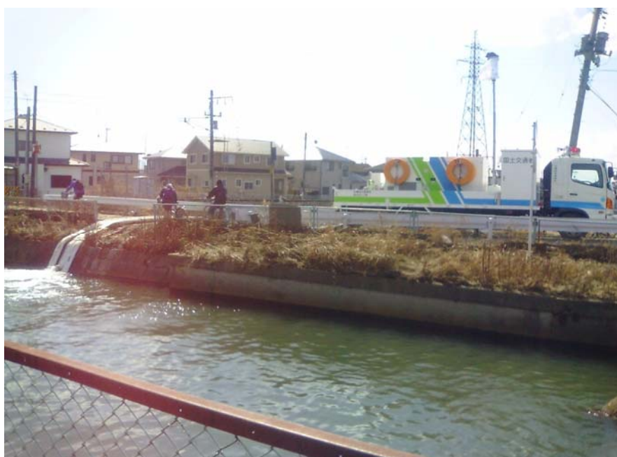
東松島市赤井 調整池での浸水解消のための排水状況
