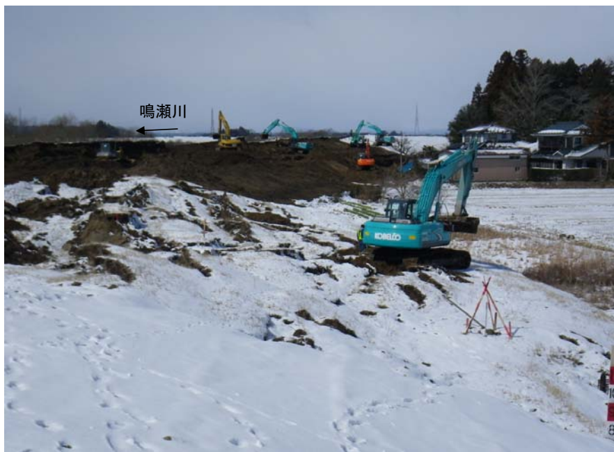
3月18日10時頃 堤防沈下の復旧盛土
