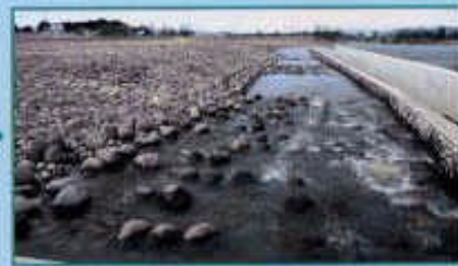
左岸魚道の状況
