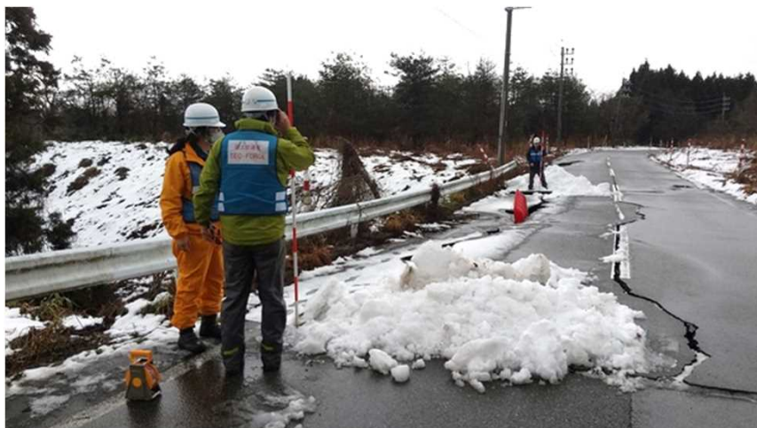
(参考) R6.1.9石川県穴水町(被災状況調査の状況)
