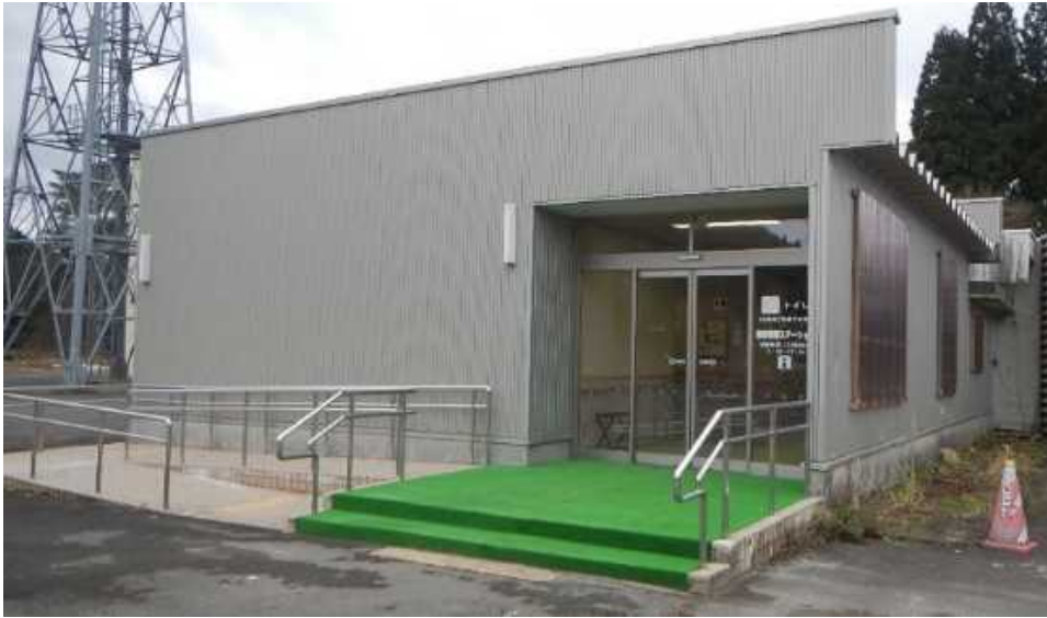
情報ステーション外観
