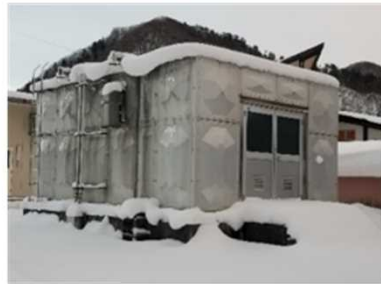
(既設)給水施設
