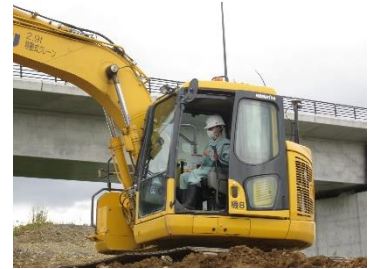
▲ICT建機搭乗体験(築堤工事)
