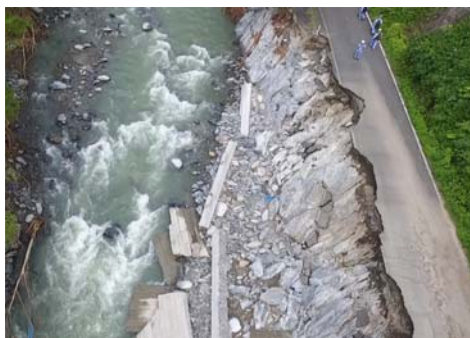
▲ ドローンを活用した被災状況調査
