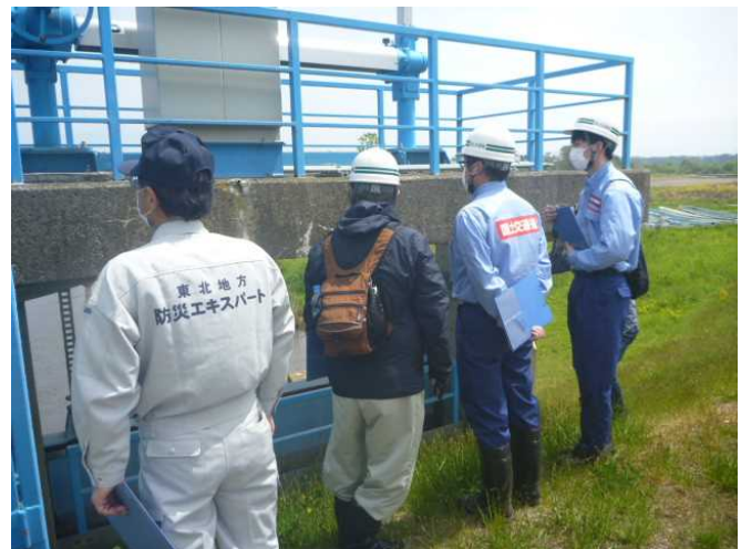
排水樋門の点検状況
