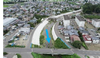
堤防嵩上げ（塩野川_伊達市）
