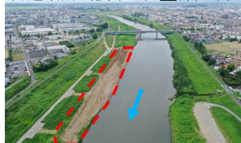
堤防嵩上げ（塩野川_伊達市）
