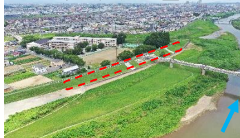
河道掘削（横塚地区_郡山市）
