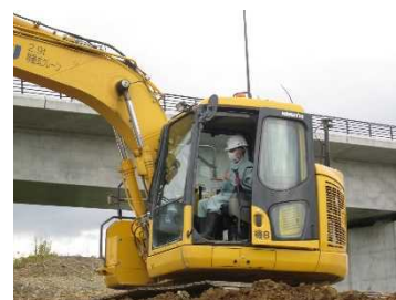
▲ICT建機搭乗体験(築堤工事)
