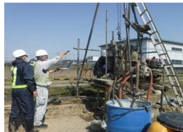
溝延地区地質調査状況
