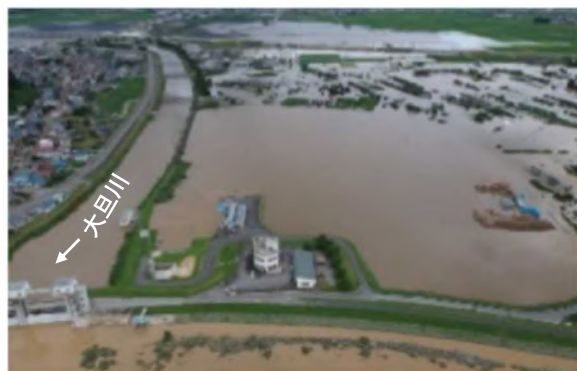
被災状況(R2.7月)
