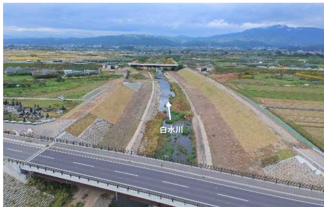
施工状況(R3.10月)
