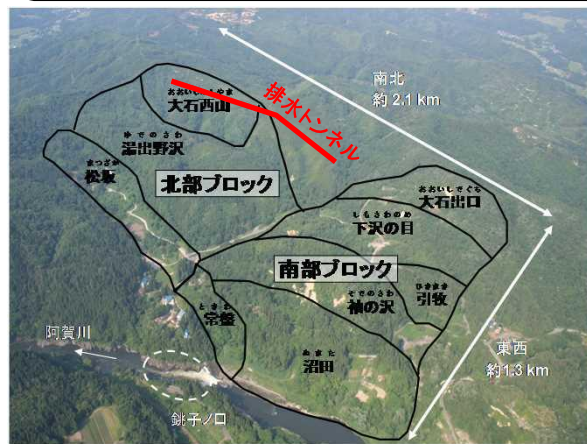
滝坂地区地すべりの全景
