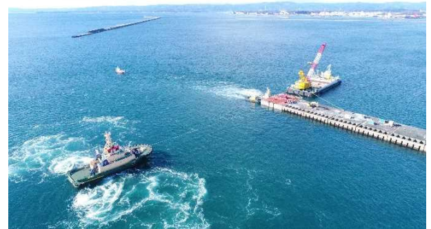
▲防波堤整備の様子(ケーソン※)据付
