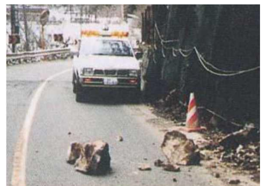
▲国道121号の落石状況
