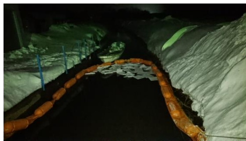
前川のオイルフェンス設置状況と吸着マット回収状況
