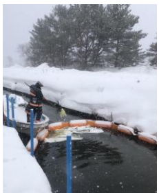
前川のオイルフェンス設置状況と吸着マット回収状況
