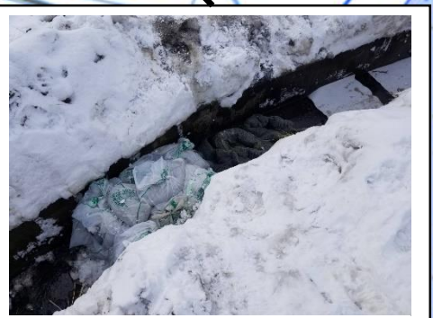
1月11日排水側溝内の土のう設置状況
