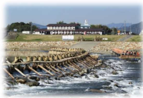
賑わい拠点の整備 (五ヶ瀬川/延岡市)
