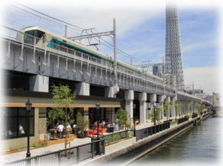
民間事業者との連携 (北十間川/墨田区)
