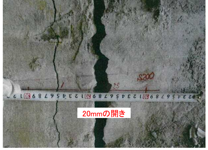
【(仮称)前波トンネル終点側(酒田側)覆工コンクリート状況】
