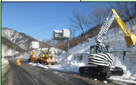
バックホウによる除去状況
