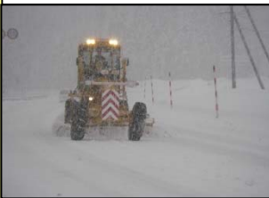
除雪グレーダによる作業状況
