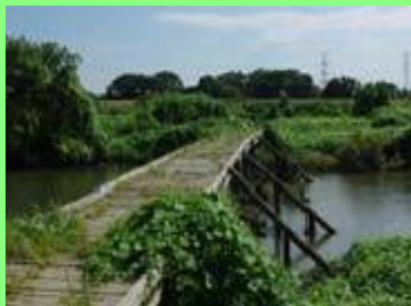
ピオトープの整備
