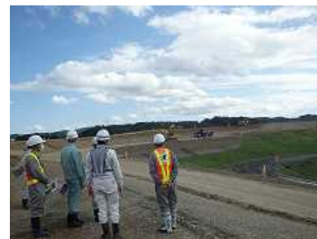
▲現地実習(築堤工事)
