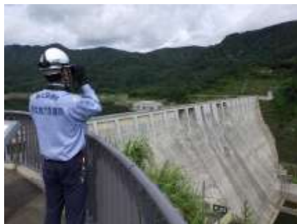
外観目視点検の様子
