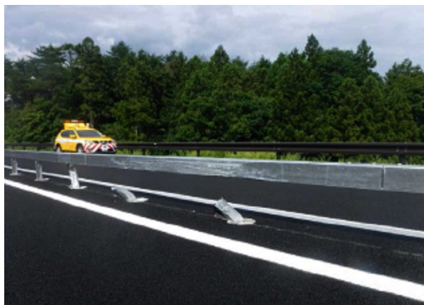
▲中央分離帯の損傷イメージ
