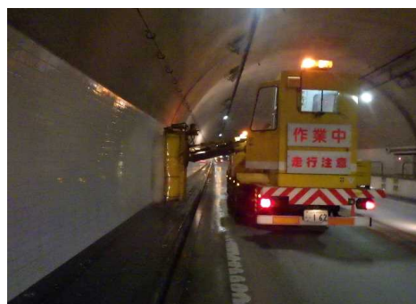
▲トンネル壁面清掃イメージ
