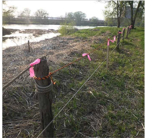
杭の打ち直しとロープの張り替えをした。
