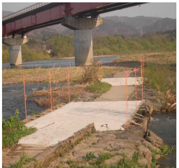
丸太への乗り上げ防止の柵を設置した。
