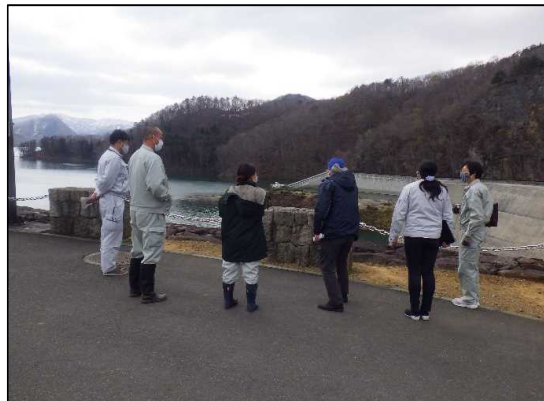
【胆沢ダム堤体天端】 異常なし
