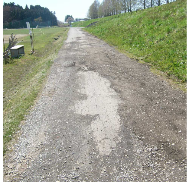
砂利敷による補修を実施した。
