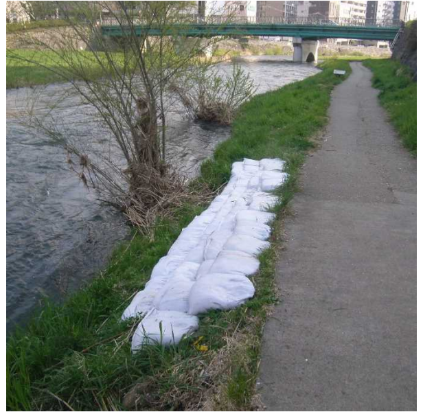
土のう設置により洗掘箇所を復旧した。
