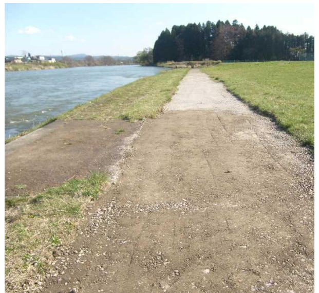
砂利道の路面を平坦にした。
