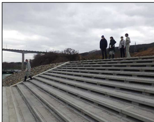
【奥州いさわカヌー競技場】 異常なし
