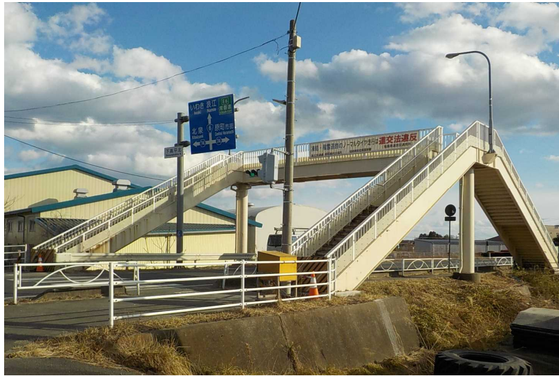
歩道橋 補修完成状況
