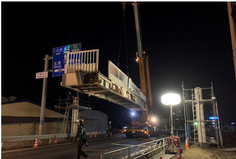
歩道橋 橋桁部の交換状況（R3. 1. 27 夜）
