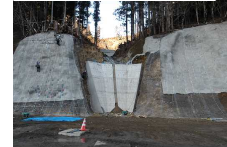
山側への擁壁完成(国交省施工)
