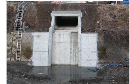
排水横断函渠完成(国交省施工)
