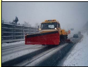
除雪トラックによる作業状況
