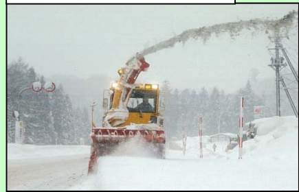
ロータリ除雪による作業状況
