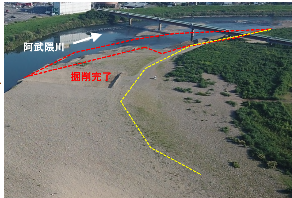
伐採・掘削後（R2.8撮影）
