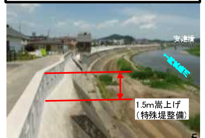
左岸地区 築堤工事完了状況
