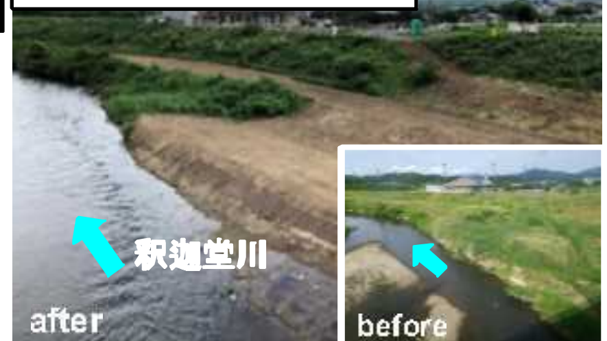
写真①(未来大橋下流側)
