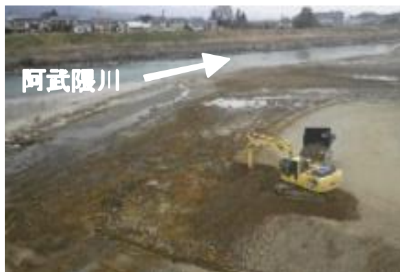
バックホウによる掘削
