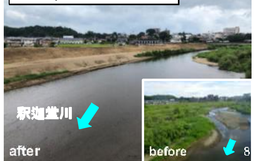
写真②(未来大橋上流側)
