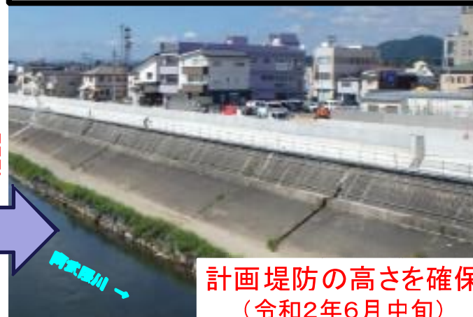
嵩上げ対策状況
