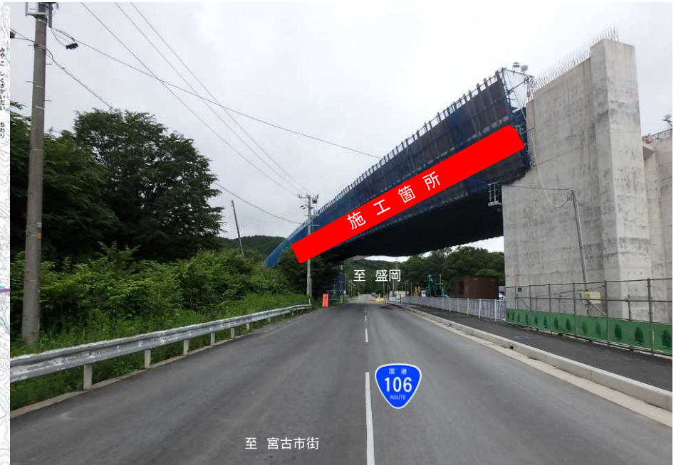
【施工箇所写真】
