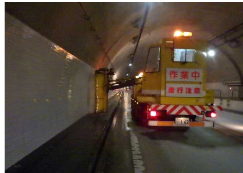
▲トンネル壁面清掃イメージ
