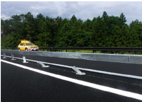
▲中央分離帯の損傷イメージ
