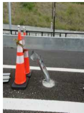
▲中央分離帯の損傷イメージ
