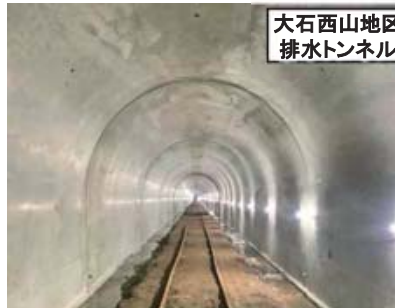
▲排水トンネル施工状況 (大石西山地区)
