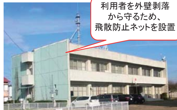
既存庁舎：老朽により外壁の剥落が発生している
