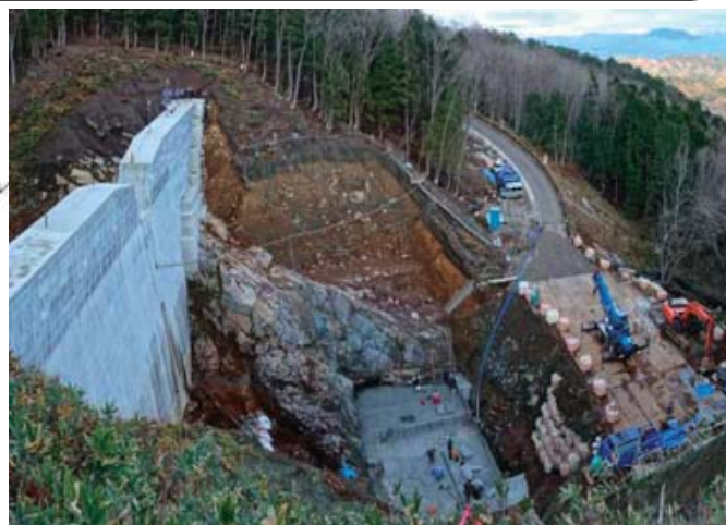
施工状況(R1)
