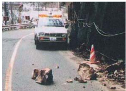
▲国道121号の落石状況
