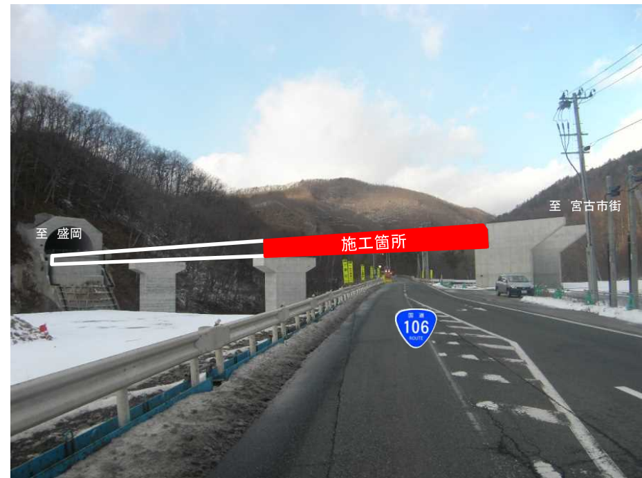
【施工箇所写真】
