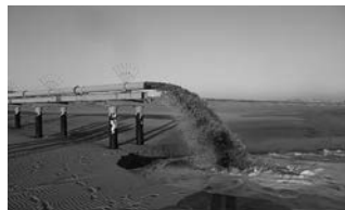
農林水産大臣賞 漁港の砂堆積と砂浜侵食を同時に保全する ジェットポンプ式サンドバイパスシステム 静岡県一一般財団法人漁港漁場漁村総合研究所・五洋建設(株)
