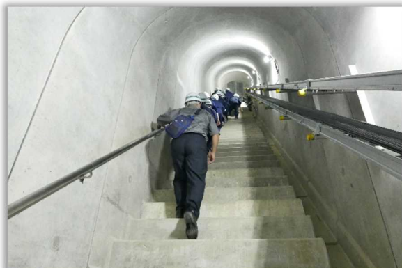
【ダム堤体内のやや高い階段を上り下りします】
