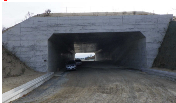
駐車場所 コンクリートボックス内
