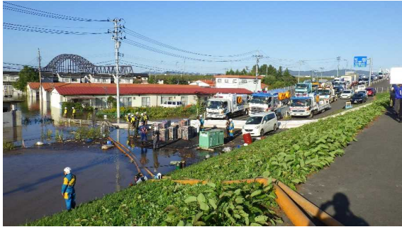
▲排水ポンプ車の配備状況
