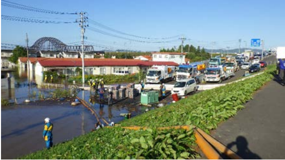
▲排水ポンプ車の配備状況
