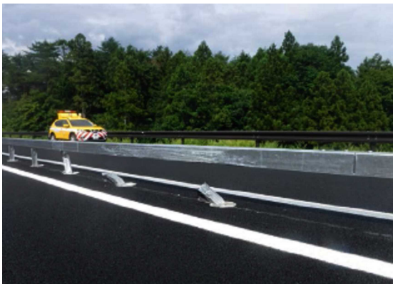
▲中央分離帯の損傷イメージ
