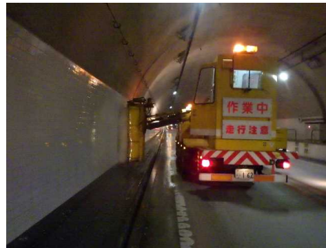
▲トンネル壁面清掃イメージ
