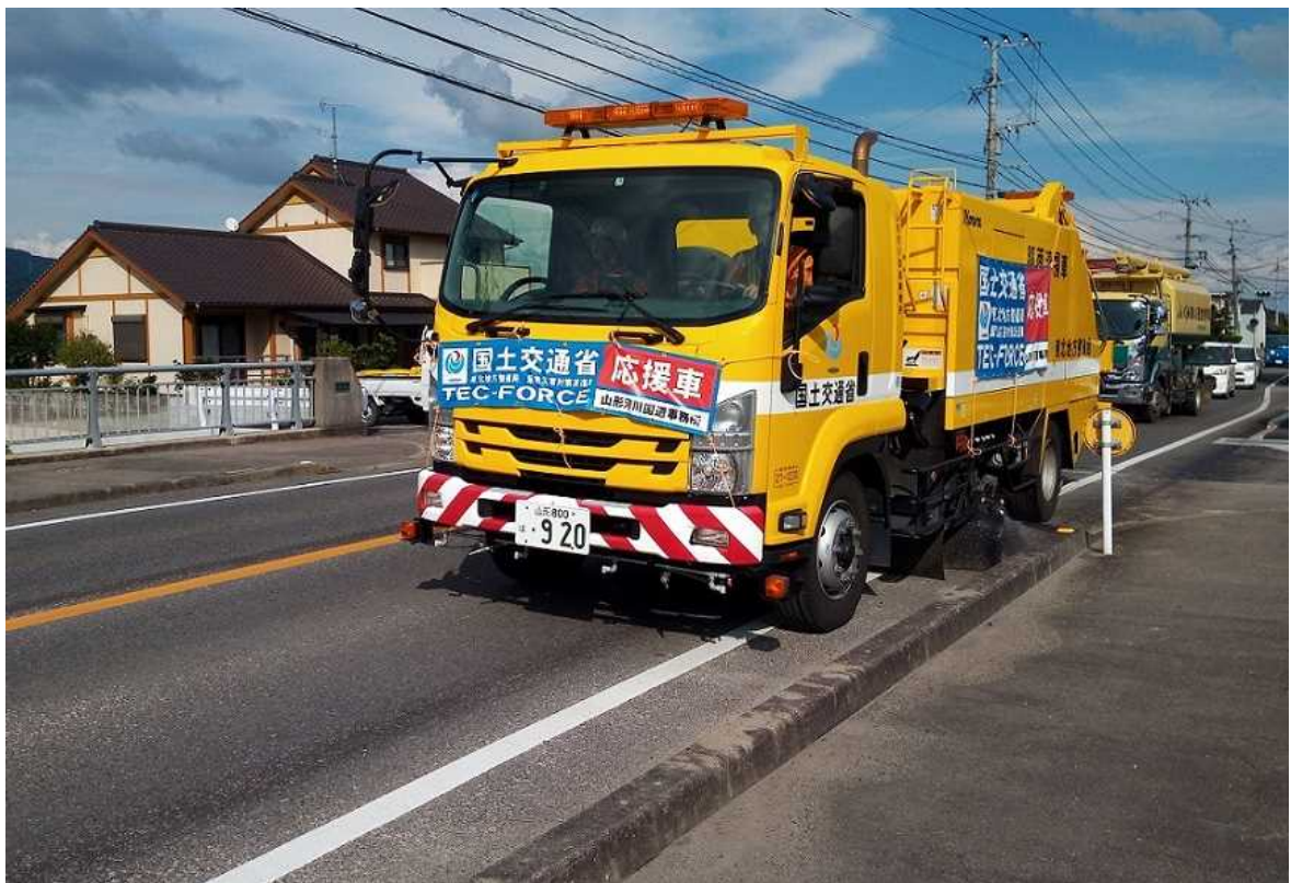
現地での路面清掃作業状況
