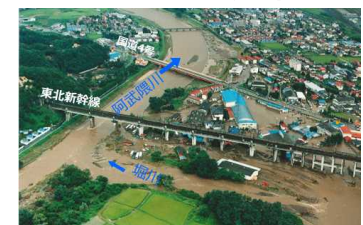
平成10年8月末洪水 白河市 堀川合流部
