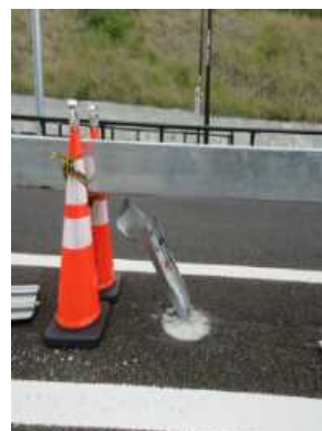
▲中央分離帯の損傷イメージ
