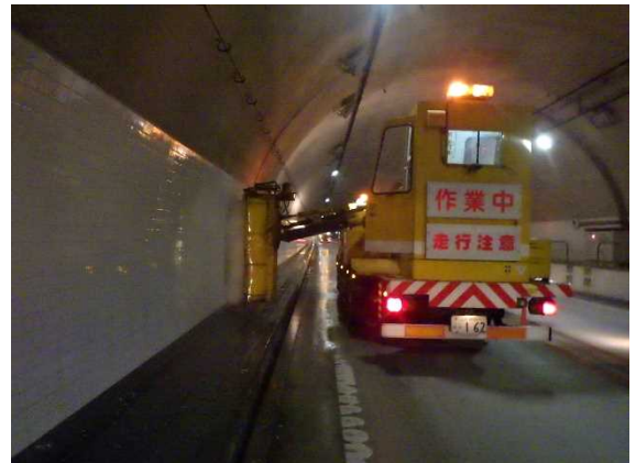
▲トンネル壁面清掃イメージ
