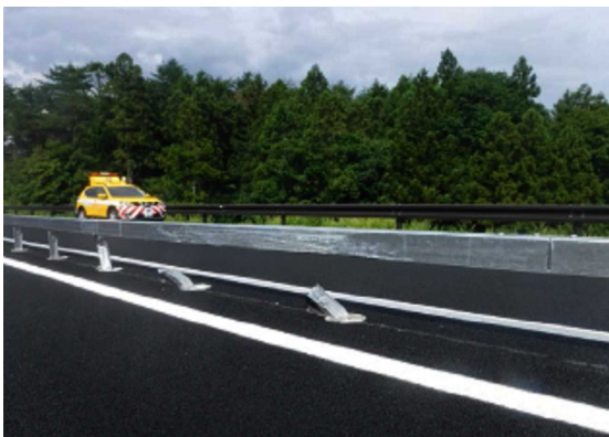
▲中央分離帯の損傷イメージ
