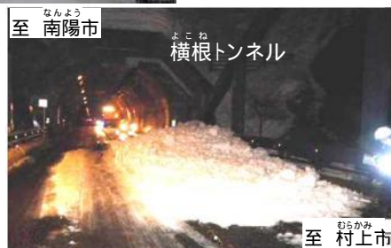
雪崩による通行止めの状況
