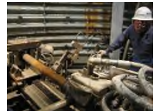
集水ホ-リング 施工状況
