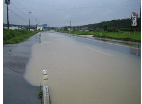
国道7号の冠水状況
