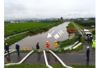
平成26年7月洪水時の状況
