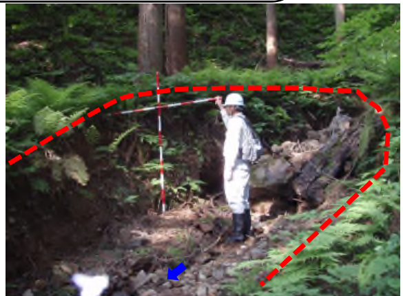
上流域の溪岸崩壊状況
