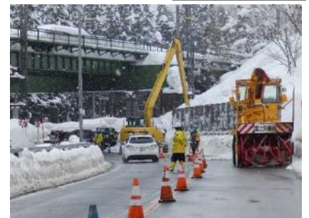
雪崩予防作業による片側交通規制
