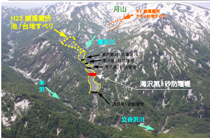
大規模崩壊後の立谷沢川流域濁沢
