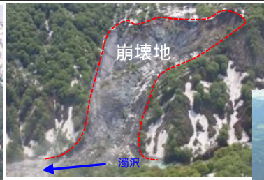
H23 崩壊状況
