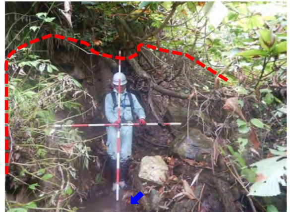
上流域の溪岸崩壊状況
