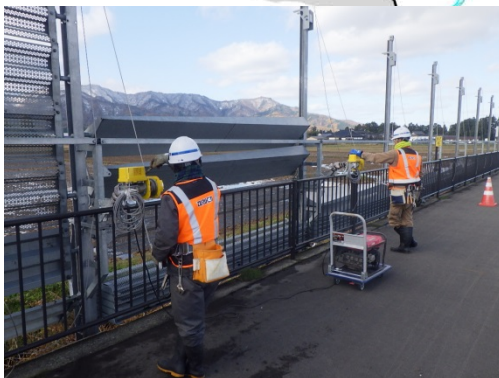
昨年度の防雪柵建て込み状況
