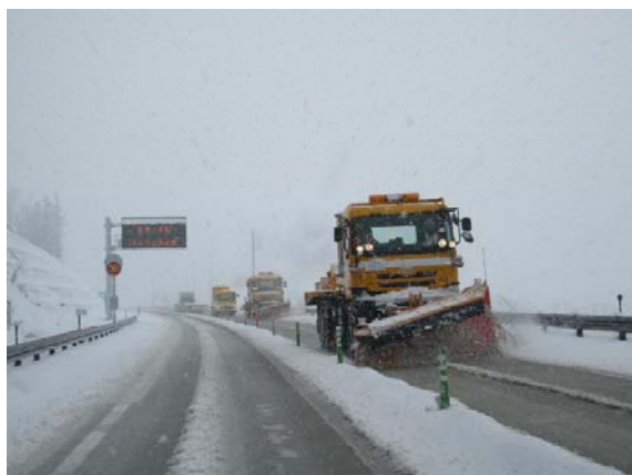
▲除雪トラックによる道路除雪作業
