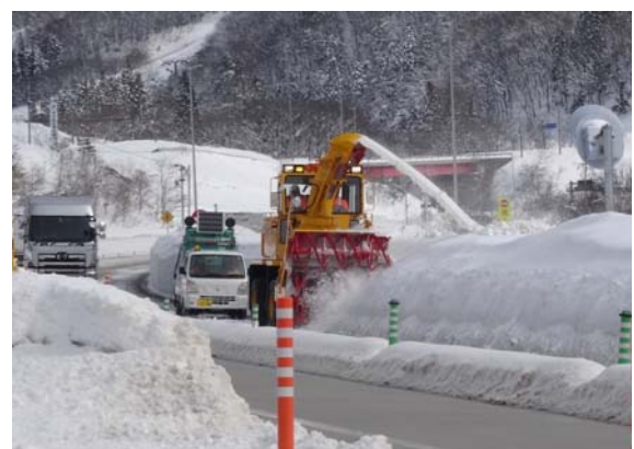
▲ロータリ除雪による道路拡幅作業
