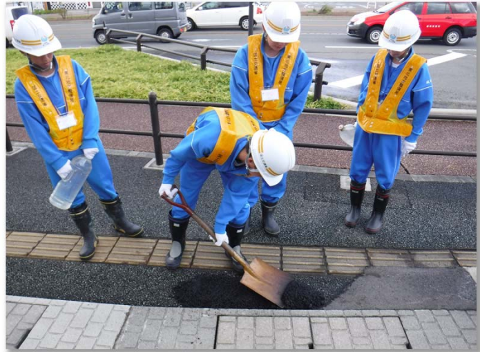
▲段差処理状況
