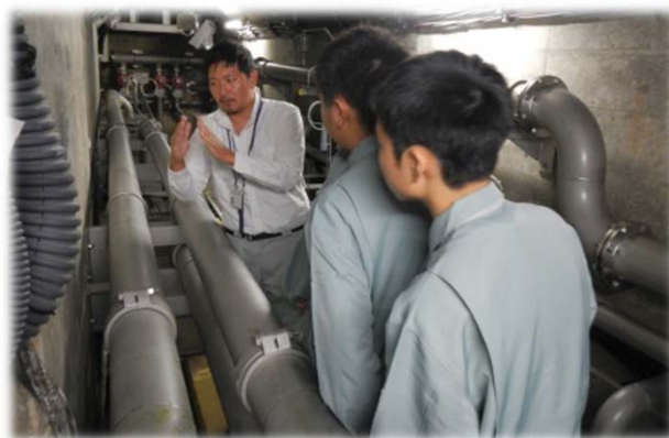
▲胆沢ダム内部の見学
