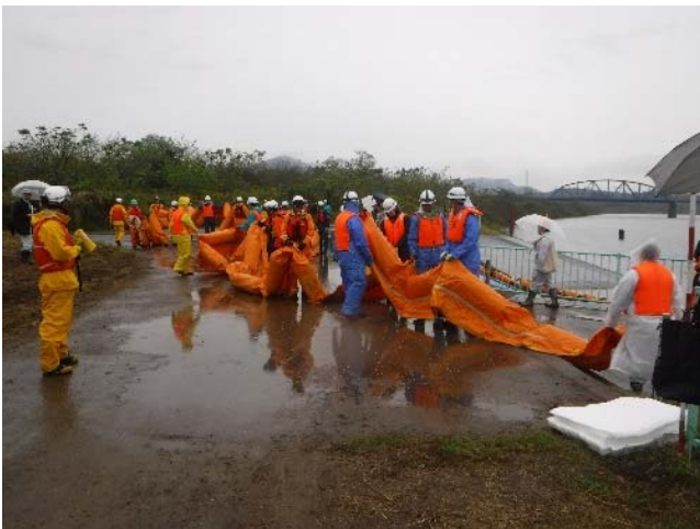
【オイルフェンス展張：送り出し】
